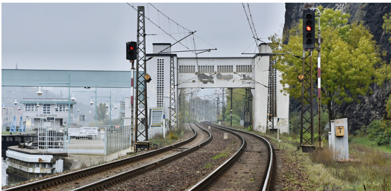
01 — V rámci optimalizace úseku Litoměřice dolní nádraží - Ústí nad Labem-Střekov dojde i k rekonstrukci zabezpečovacího zařízení
