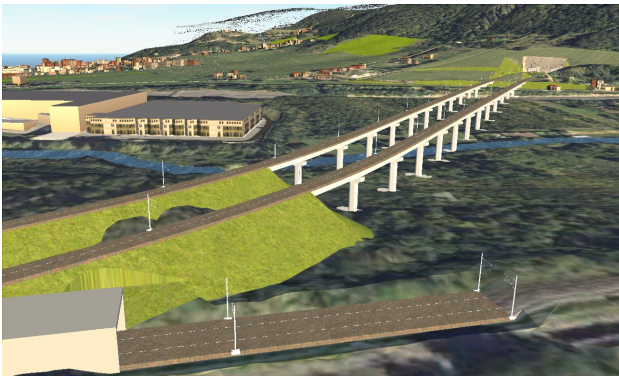
Obrázek 7 – pohled na jednokolejné estakády za západním portálem tunelu Dubice před Trmicemi
